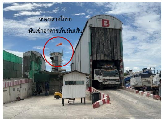
รูปที่ 2-22 ทิศทางของปลายท่อเครื่องดักจับฝุ่น (Bag Filter) ของโกรกกลิ้งสินค้า A และโกรกกลิ้งสินค้า B
