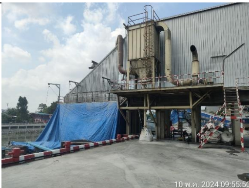
ท่อดูดฝุ่นจากผ้าใบเรือเข้าสู่เครื่องดักจับฝุ่นบริเวณโรงกลั่นสินค้า A
