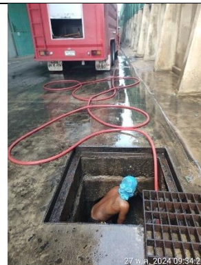
รูปที่ 2-32 ภาพการทำความสะอาดและขุดลอกท่อระบายน้ำ Manhole บ่อพักน้ำทิ้ง
