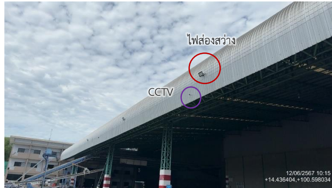
รูปที่ 2-47 การติดตั้ง CCTV และไฟส่องสว่างบริเวณท่าเทียบเรือ
