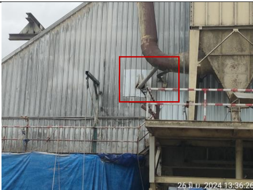
ท่อดูดฝุ่นจากผ้าใบเรือเข้าสู่เครื่องดักจับฝุ่นบริเวณโรงกลั่นสินค้า A
