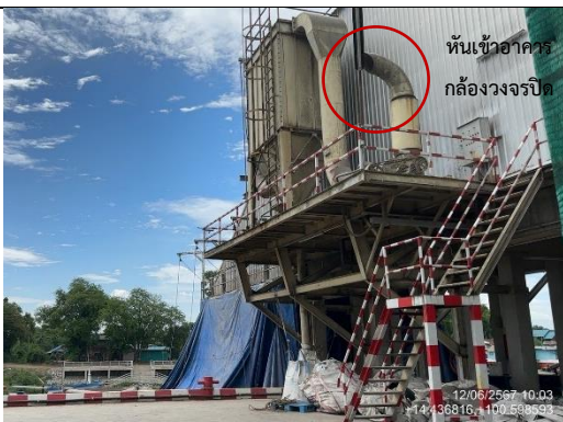
รูปที่ 2-22 ทิศทางของปลายท่อเครื่องดักจับฝุ่น (Bag Filter) ของโกรกกลิ้งสินค้า A และโกรกกลิ้งสินค้า B
