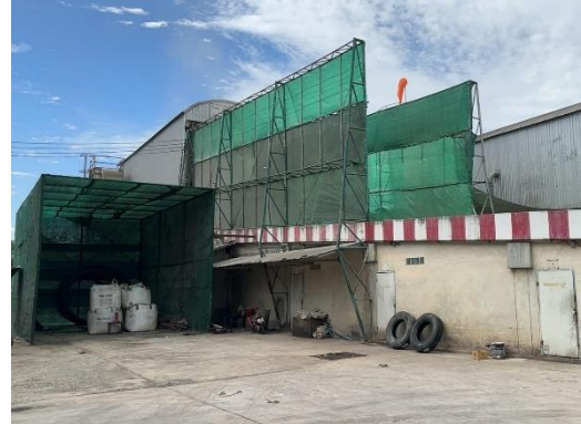
รูปที่ 2-6 เครื่องดักจับฝุ่น ติดกับโกรกลงสินค้า A พร้อมมีการติดตามถ่ายกันฝุ่นบริเวณทางขึ้นโกรกลงสินค้า A
