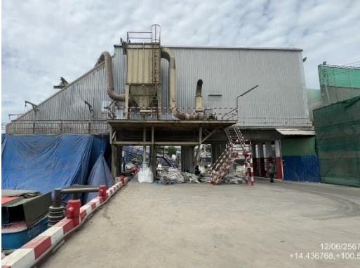
รูปที่ 2-6 เครื่องดักจับฝุ่น ติดกับโกรกลงสินค้า A พร้อมมีการติดตามถ่ายกันฝุ่นบริเวณทางขึ้นโกรกลงสินค้า A
